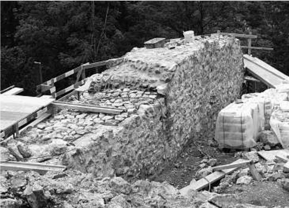
Abb. 5: Unterer Mannenberg. Wiederaufmauerung der obersten Mauerlagen. Blick auf die östliche Ringmauer von Norden.
