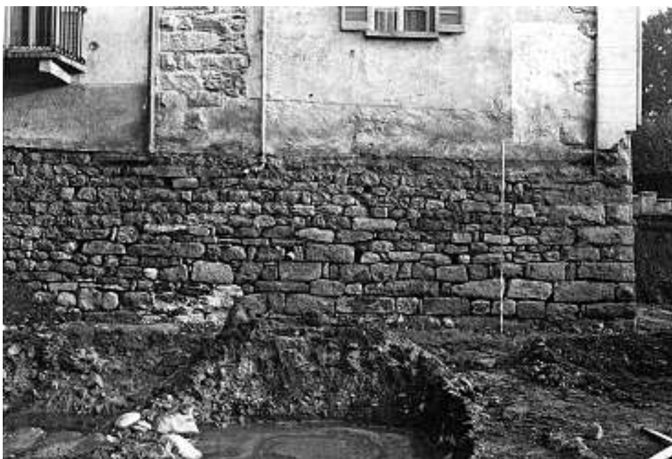
Abb. 22: Ascona, Cast. dei Griglioni. Südwestturm (B). Freigelegtes Fundament von Turm und Kurtine (1967).
