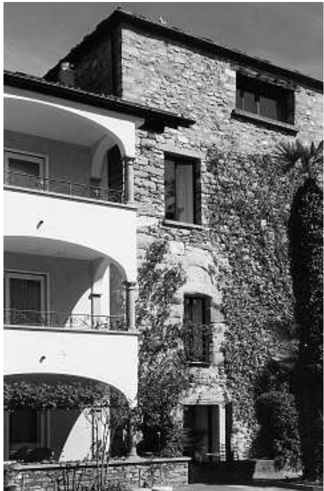
Abb. 17: Ascona, Cast. dei Griglioni. Nordostturm (B) von Süden (Burghof). Im 2. Geschoss (vom Hofniveau an) ist über dem Fenster der Rundbogen des ehem. Hocheinganges erkennbar.
