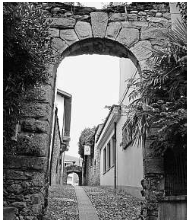
Abb. 29: Ascona, Cast. dei Griglioni. Südtor, Ansicht von aussen (Süden). Durch Absenken der Fahrbahn mussten die Torwangen nach unten verlängert werden.
