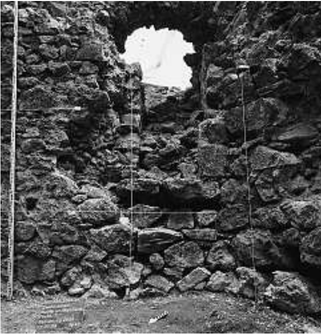
Abb. 8: Unterer Mannenberg, Maueröffnung des Türchens in der Westwand des mutmasslichen Turmes. Blick von Westen.
