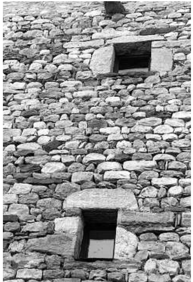
Abb. 15: Ascona, Cast. dei Grigioni. Fenster im Nordostturm (B).
