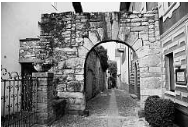
Abb. 26: Ascona, Cast. dei Griglioni. Nordtor, Ansicht von aussen (Norden). Der Rundbogen ist mit zwei Keilsteinen im Scheitel geschlossen. Ebenfalls gut erkennbar sind die beiden zugemauerten Rutenkanäle für eine allfällige Zugbrücke.
