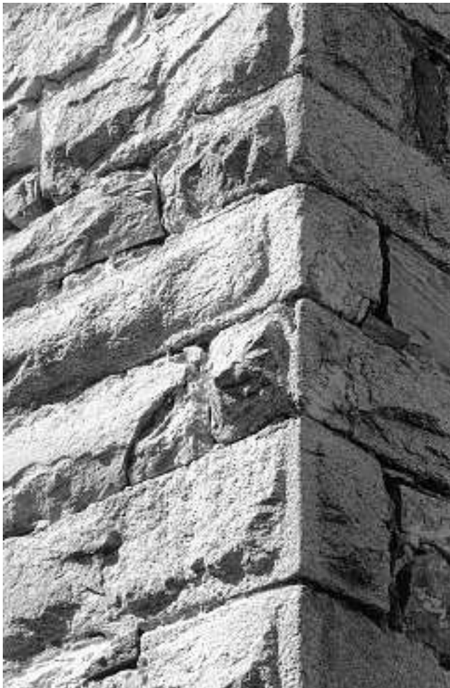
Abb. 20: Ascona, Cast. dei Griglioni. Detailansicht der bossierten Eckquader am Nordostturm (B).
