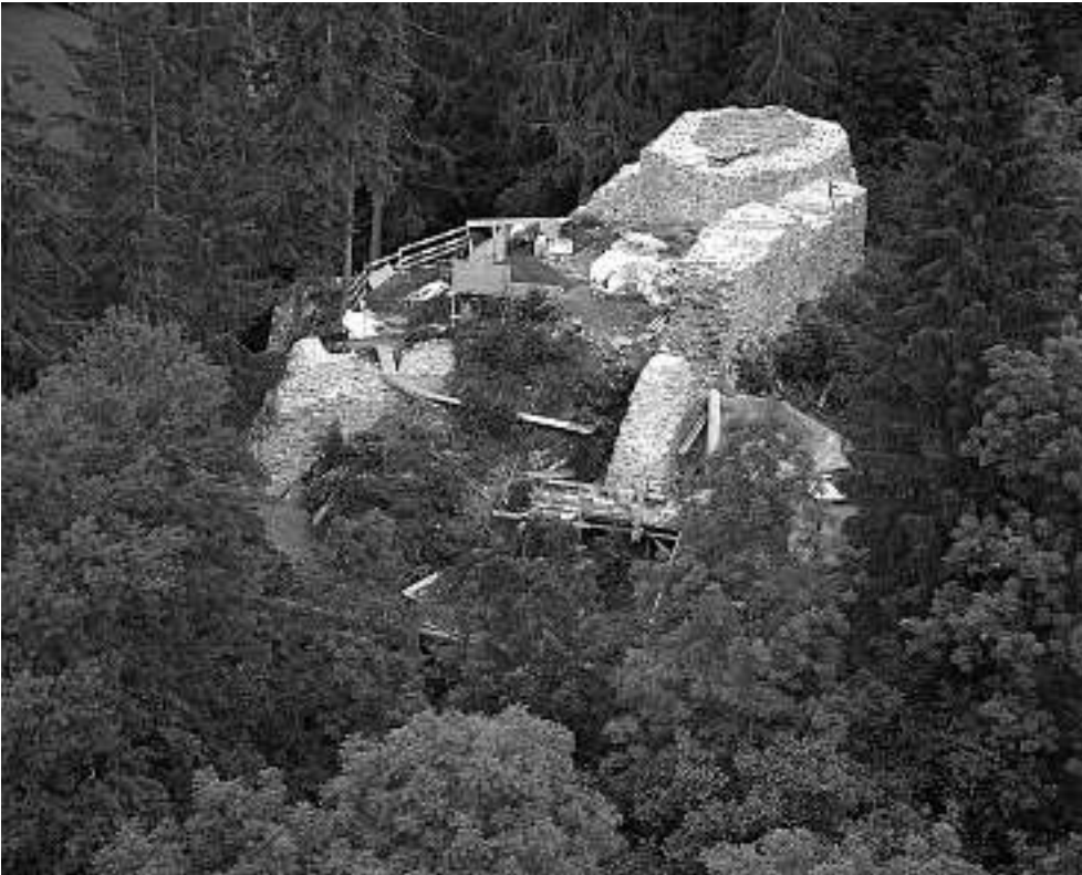
Abb. 10: Unterer Mannenberg. Die Burganlage während der Sanierung. Deutlich ist der Steilabbruch rechts von der Anlage zu erkennen. Luftaufnahme, Blick von Nordwesten.
