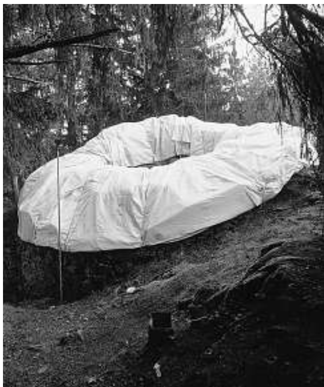
Abb. 4: Unterer Mannenberg. Die eingepackte Ruine des Rundturmes nach der Rodungsaktion von 2004. Blick von Süden, gleiche Blickrichtung wie Umschlagbild.
