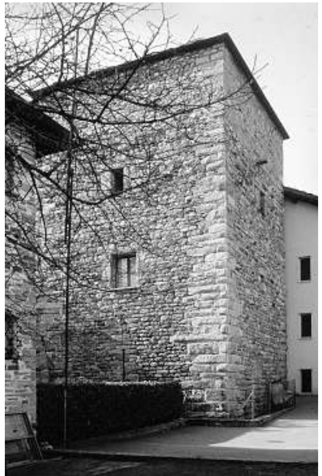
Abb. 19: Ascona, Cast. dei Griglioni. Nordostturm (B). Ansicht der Südostecke mit bossierten Eckquadern.
