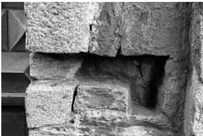
Abb. 31: Ascona, Cast. dei Griglioni. Nordtor, Einschubnut für Sperrbalken.
