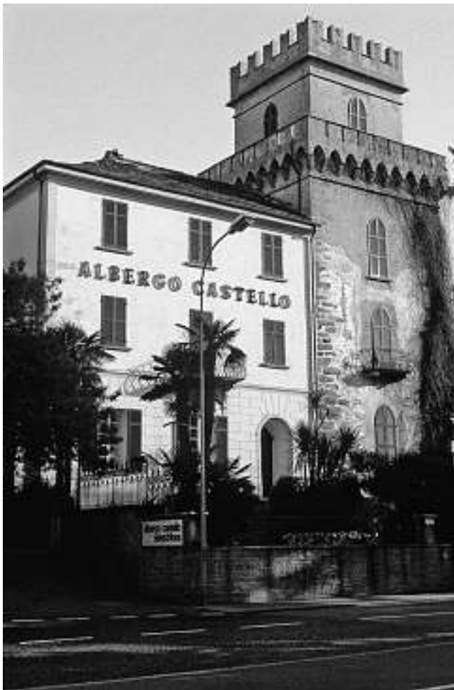
Abb. 18: Ascona, Cast. dei Griglioni. Südostturm (A) mit Zinnenkranz und aufgesetztem Zinntürmchen. Um das Fenster im 2. Geschoss des Turmes sind die Reste einer ehemaligen Fassadenmalerei (Wappen?) erkennbar.
