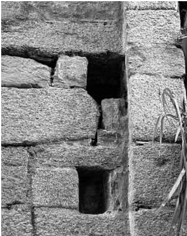
Abb. 30: Ascona, Cast. dei Griglioni. Südtor, Kopfloch für zwei Sperrbalken.
