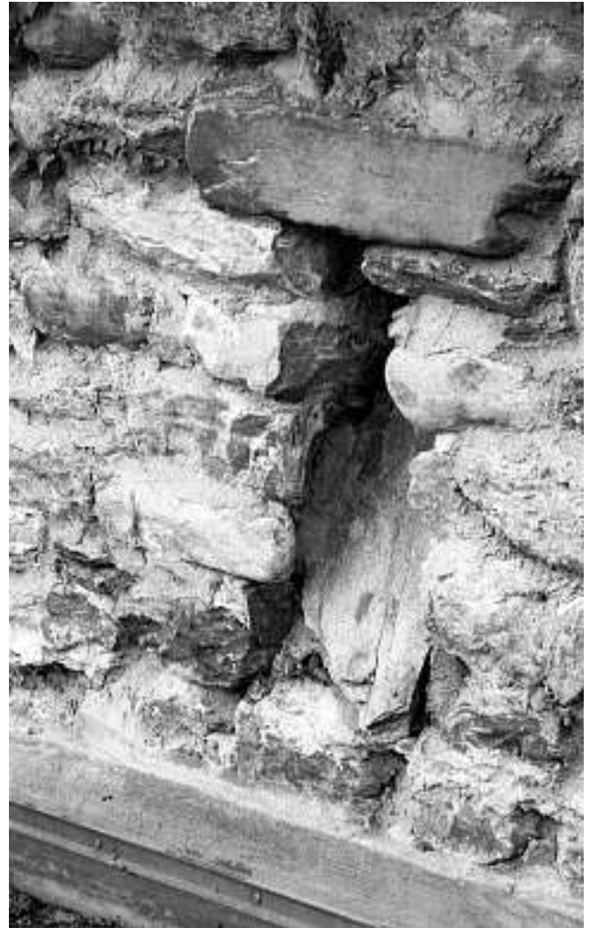
Abb. 24: Ascona, Cast. dei Griglioni. Ausgussöffnung (K) in der Ostkurtine. Vermutlich Fallschacht für einen Abort.
